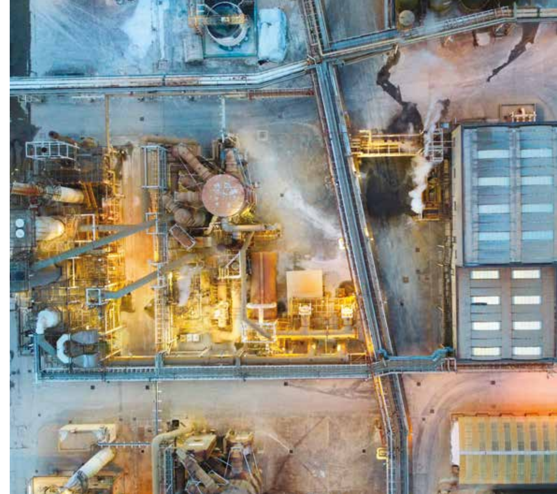
Vista dall'alto dell'impianto di acido solforico.
